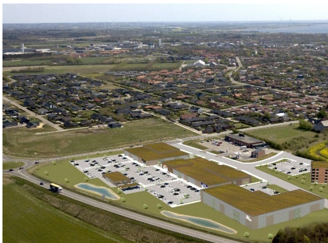
Sedum på taget kan anvendes til forsinkelse af overfladevand.
